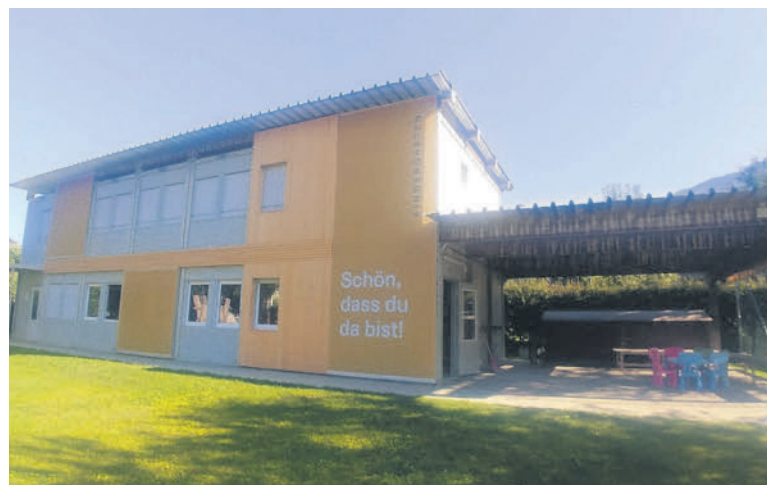
In Satteins wurde die provisorische Kinderbetreuungsstätte teilweise mit einem bedruckten Textilgewebe überzogen.
